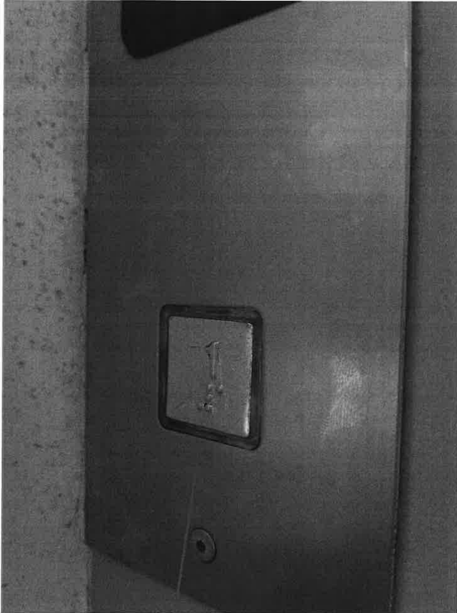
POPRAVLJENA TIPKA (ZAMENJAN NOSILEC)
